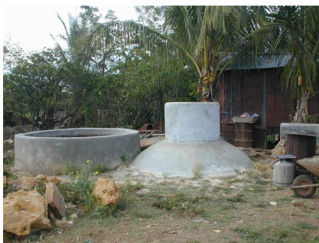
Fig. 3: Biodigestor de cúpula fija, modelo chino.
