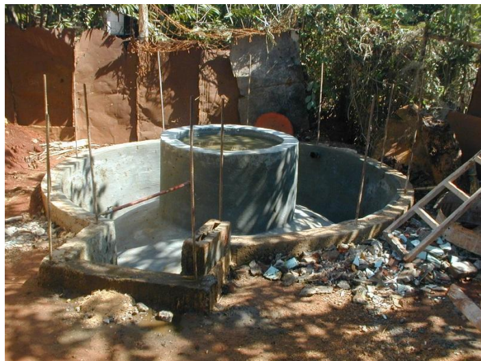
Fig. 9: Biodigestor de cúpula fija con laguna de compensación encima de la cúpula (recién terminado de construir).
