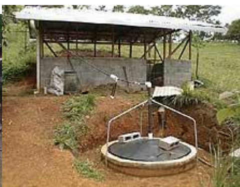
Fig.2. Biodigestor de campana flotante, modelo hindú con contrapesos para aumentar la presión del biogás
